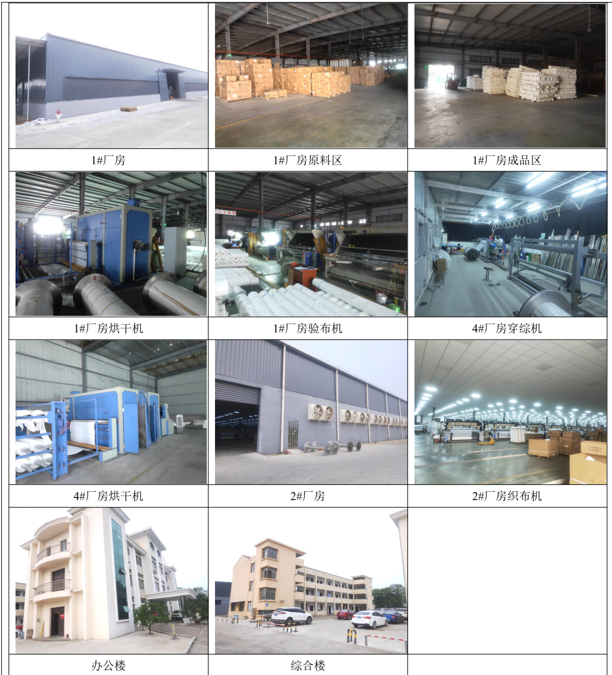
图 2-1 项目现场情况图片
